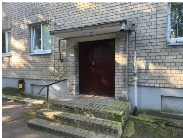
Ieeja mājas kāpņu telpa
